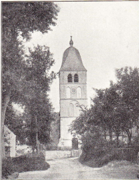
L'église d'Itterbeek, avant la restauration (1893)
